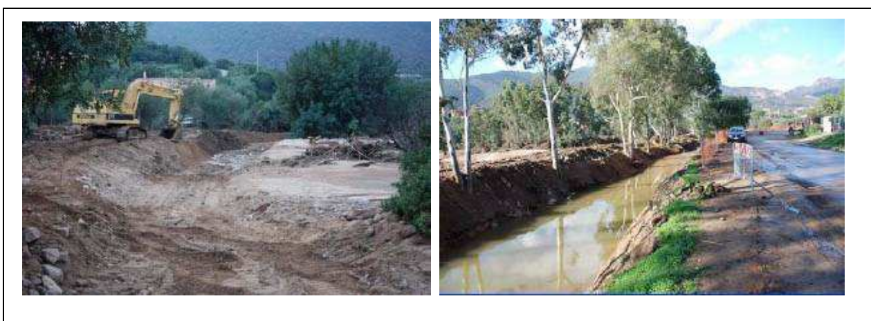
Figura 70 – Realizzazione del canale diversivo.
