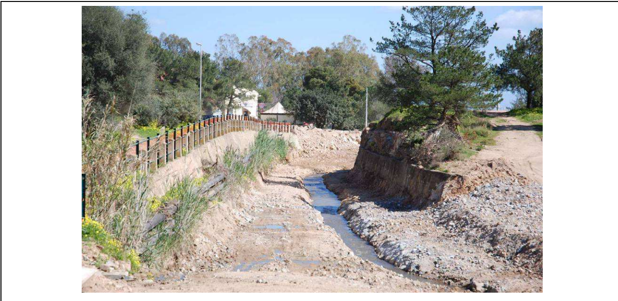
Figura 73 – Lavori sul canale di scolo ultimati.
