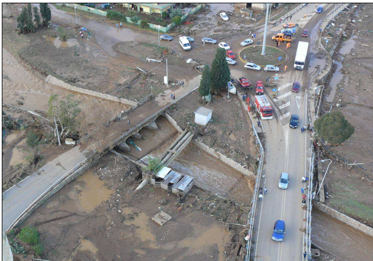
Figura 78 - Due ponti e una condotta idrica riducono, nello spazio di poche decine di metri, la sezione idraulica del Rio San Gerolamo in prossimità della foce.
