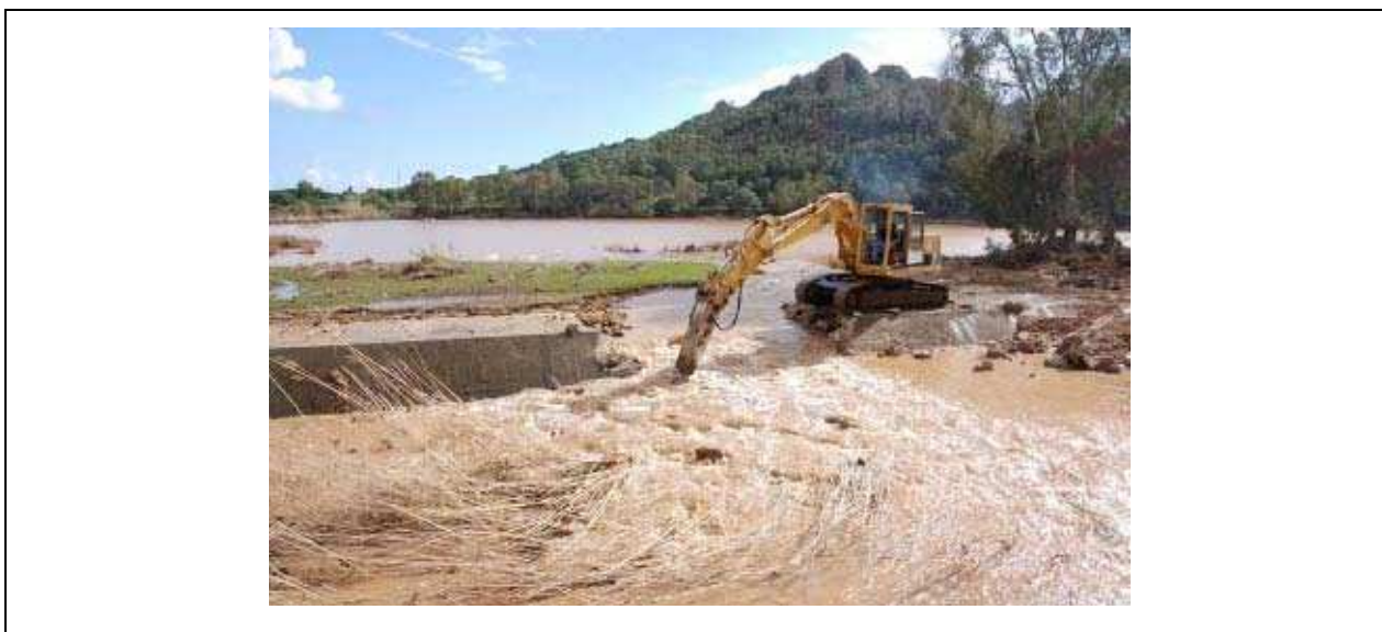
Figura 69 - Demolizione soglia sfiorante e abbassamento del livello del lago di circa 1.3 m –23.10.08
